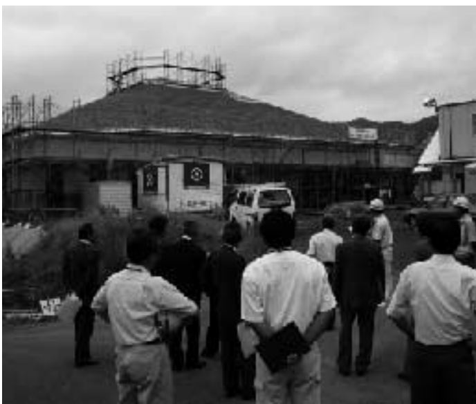
屋根工事が進む乙亥会館
