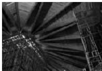
乙亥会館 内部天井の支保工
