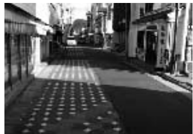
継ぎはぎのインターロッキング舗装
