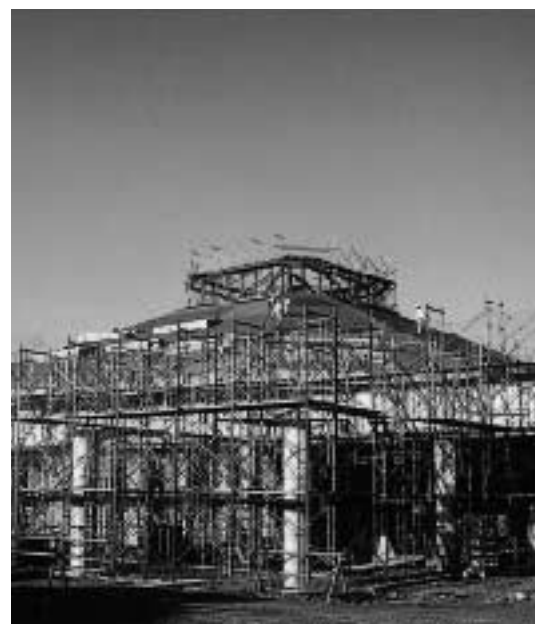
建設進む乙亥ドームは最後の大型ハコモノか
