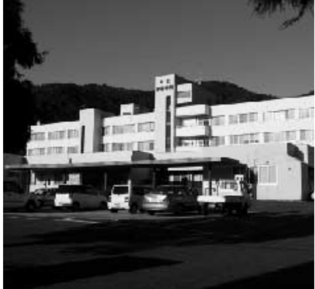
老朽化が進む宇和病院
