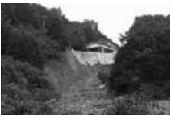
愛野地区ライスセンターに土石流
