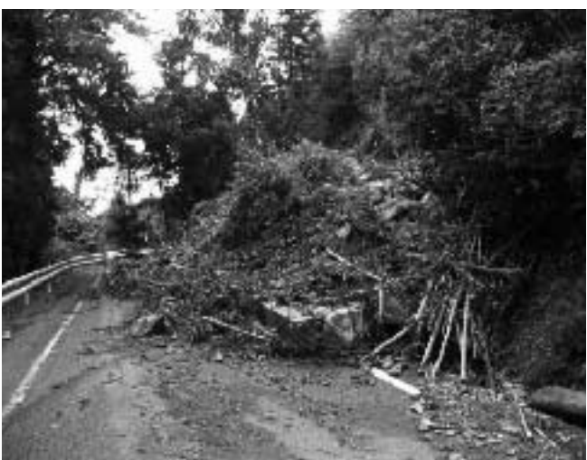
高瀬地区の山留崩壊現場
